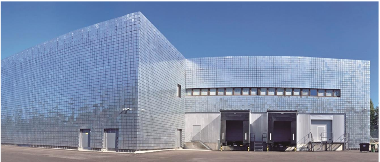
芬兰-数据中心
